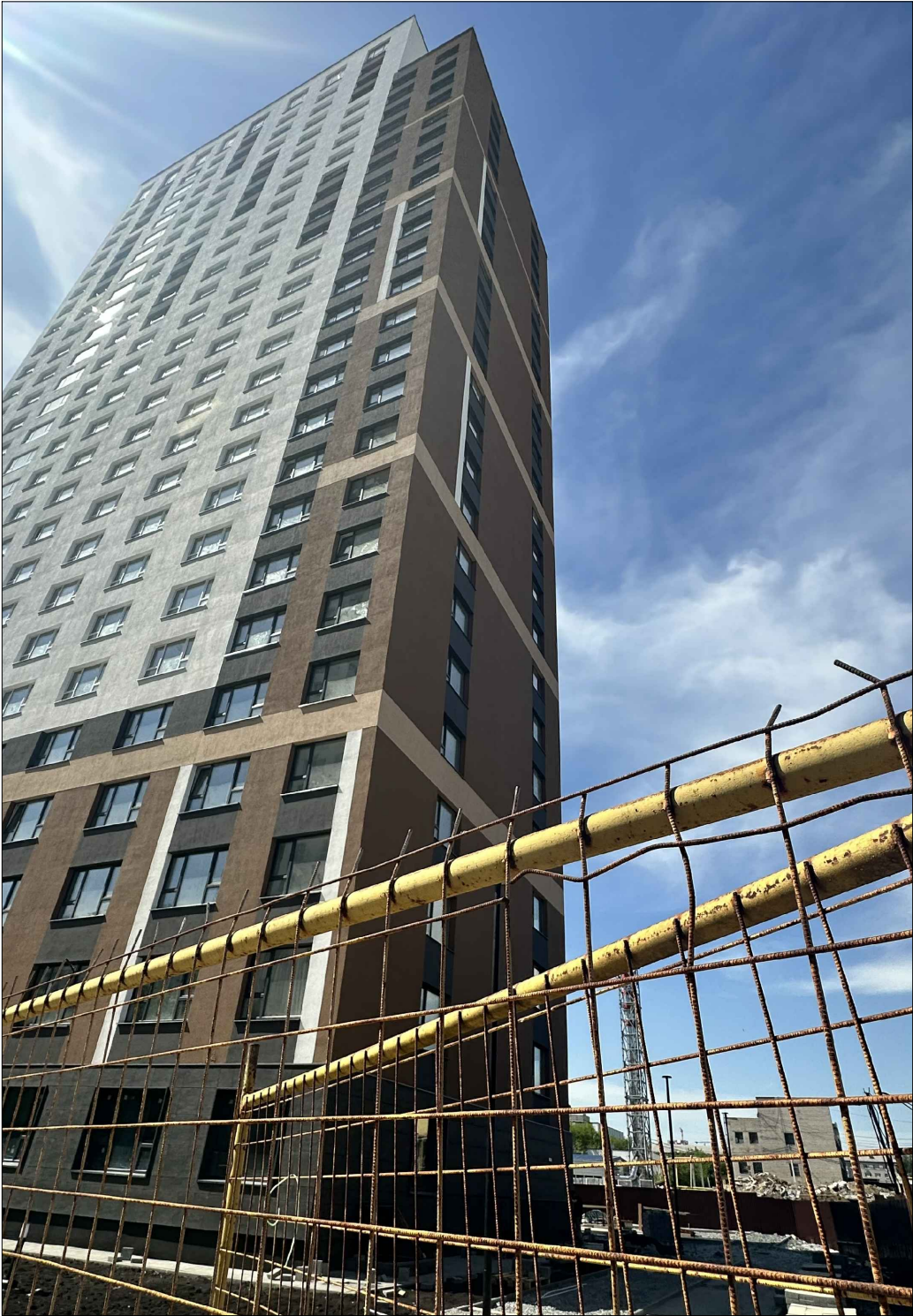
Фасад торцевой со стороны завода СИЗ
