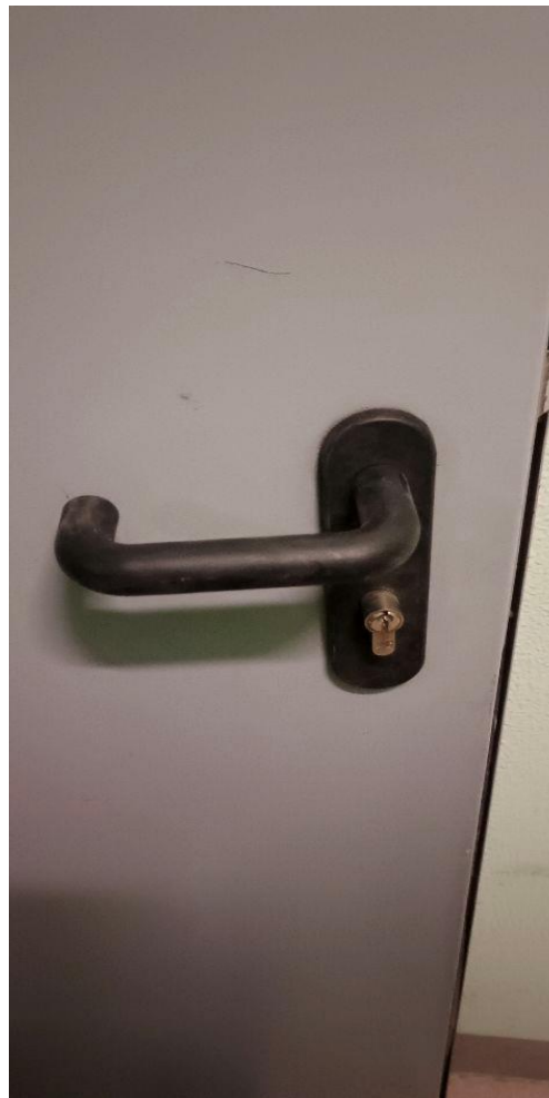
Замена ручки на двери в паркинг -1 уровень, 3 подъезд
