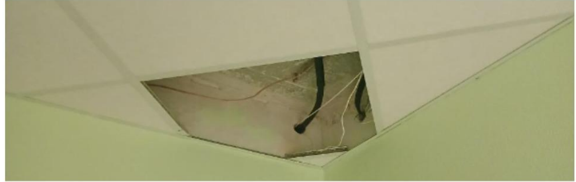
Правка потолочной плитки
