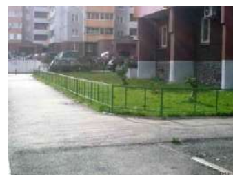
20 Газонное ограждение ГО-01 iskraekb@mail.ru
