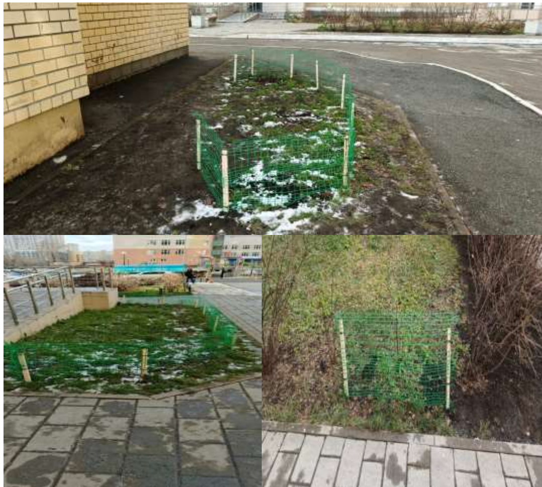
Замена арматуры на деревянные бруски в декоративном ограждении
