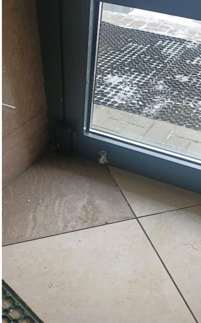
Замена стопора на двери в 1 подъезде
