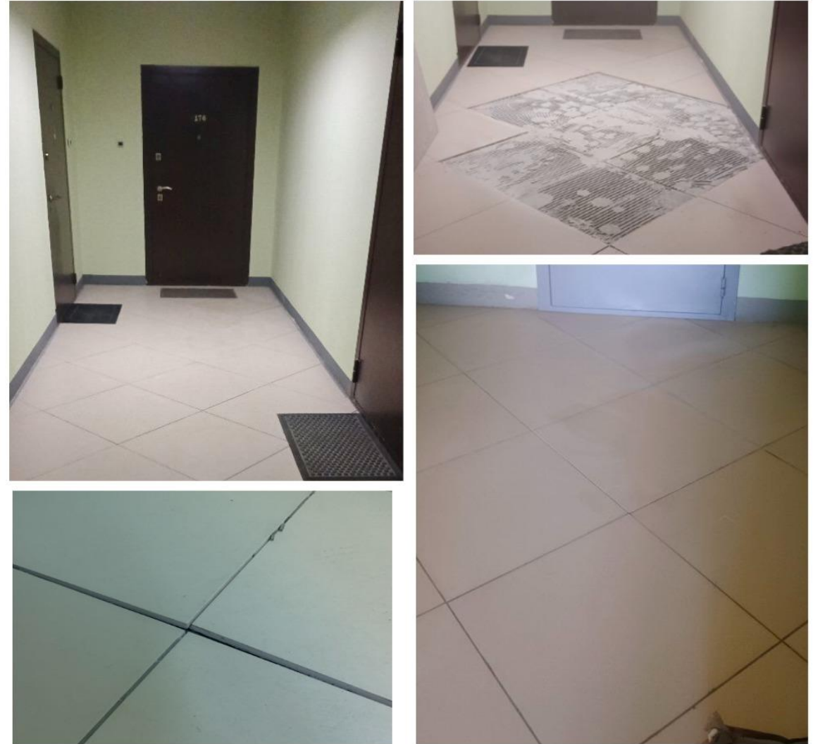
Ремонт плитки 1 и 3 подъезды
