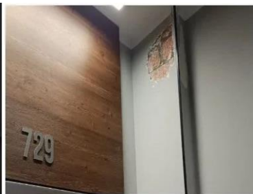
Секция Е, этажи с 1 по 20 устранены трещины и отслоения
